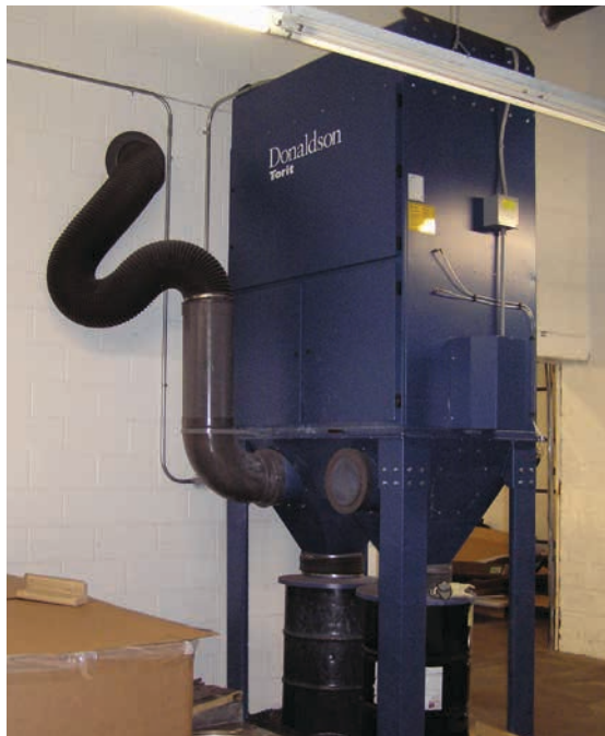
UMA 450 - Filtering Plastic from a CNC Machine
